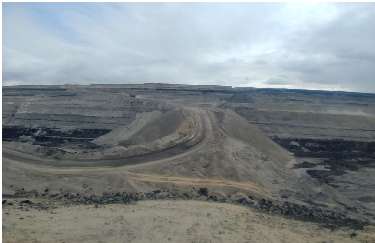
Гулсалтын хүчийг сааруулах тулгуур мост хийсэн байдал.
